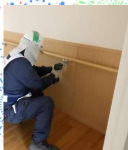
手すり・洗面台取り外し作業の様子
