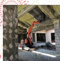
内部解体作業の様子
