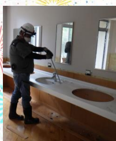
手すり・洗面台取り外し作業の様子
